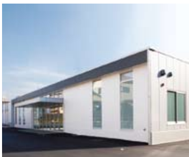
『大八技術開発センター』創業の地である東大阪に新設
