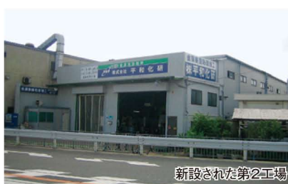
新設された第2工場
