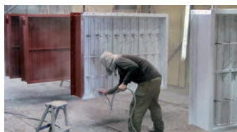
塗料を吹き付ける作業
