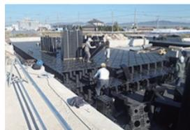
貯留槽工事は1級造水管理技術者が施工管理。掘削・基礎工事後、貯留槽ユニットを組み立て、保護シートを被せて仕上げる。さらに土を被せ、地中に埋め込む
