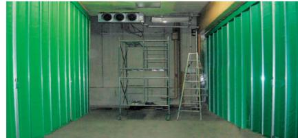
壁に断熱材を入れてOSエコレールで仕切り、内部にエアコンをきかせると倉庫が簡易冷蔵庫に
