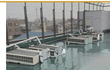
2018年の台風21号では暴風によって屋上の室外機が何台も倒れてしまい、建屋の窓ガラスが割れるなど、これまでにない被害を受けた
