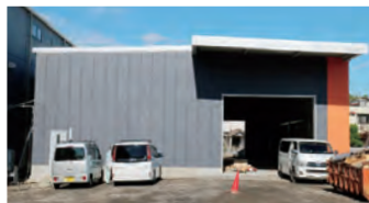
加工・組立工程を担う新工場
