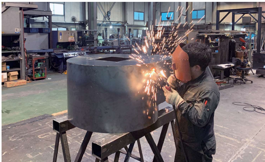
第一工場での溶接作業
