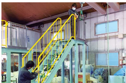
階段の寸法検査。検査確認を徹底
