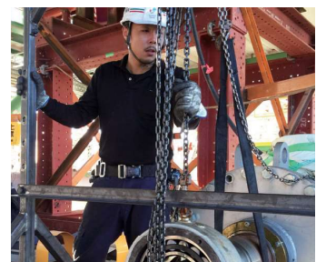
発電施設の機器メンテナンス工事
