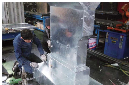
ケーブルダクト製作
