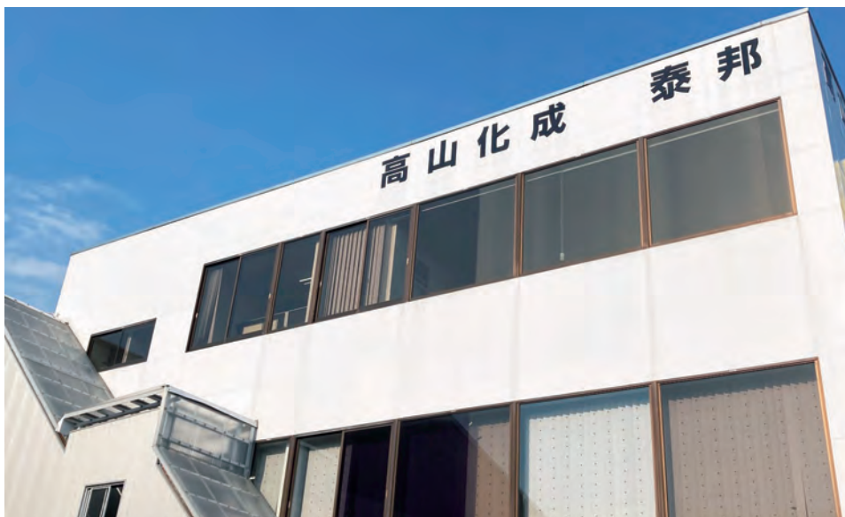
大阪府八尾市に構える本社建物
