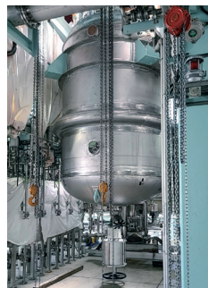
現場での架台据付工事
